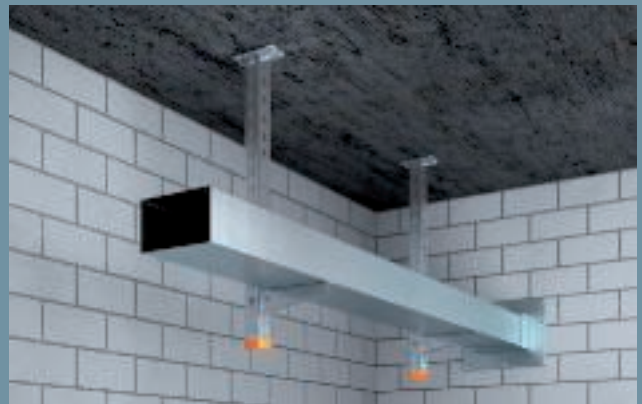
Abgehängte Montage auf Montagesystem
