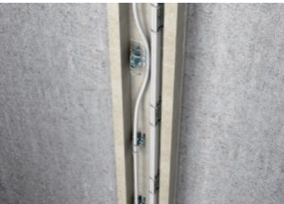
Installations de câbles verticales grâce aux porte-câbles
