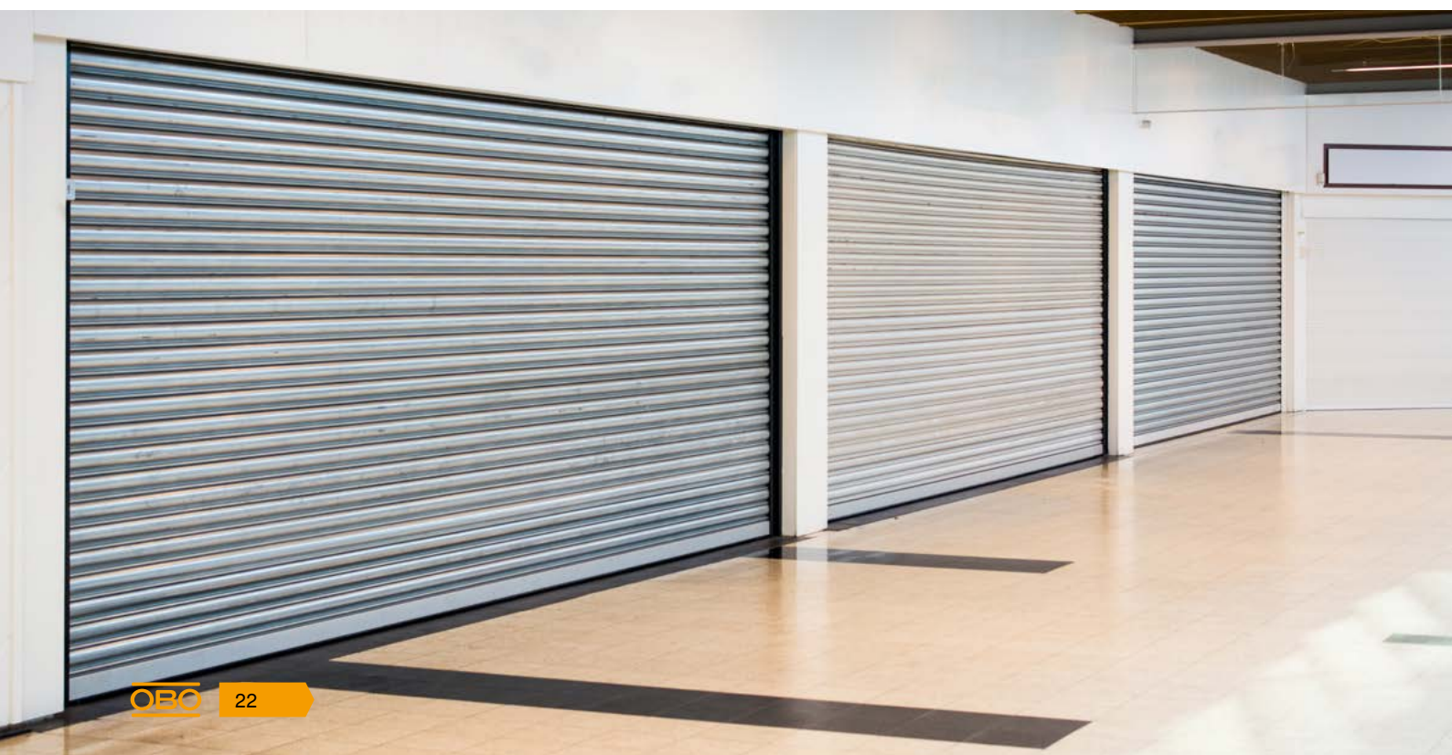
Rolltore mit Feuerwiderstandsklasse als Feuerschutzabschluss
