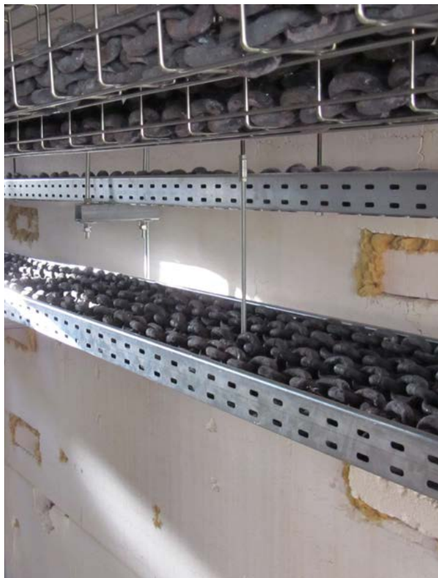
Kabelrinne mit hoher mechanischer Last vor...
