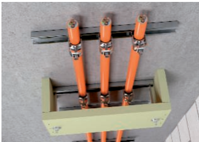
Wirksame Unterstützungsmaßnahme mit der Zugentlastung ZSE90.
