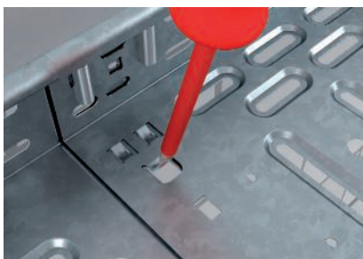
Umbiegen der Sicherungslaschen im Boden.
