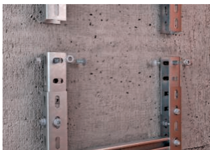
Stoßstellenausführung mit verschraubtem Verbinder.
