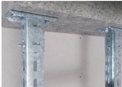
Deckenbefestigung der Leiterholme mit angeschraubten Kopfplatten.
