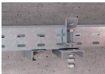
Befestigung des schrägen Anschlussbauteils.
