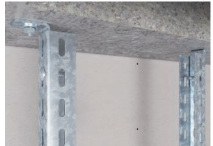
Deckenbefestigung der Leiterholme mit angeschraubten Montagewinkeln.
