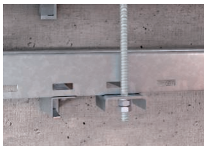
Befestigung der senkrechten Gewindestange am Anschlussbauteil.
