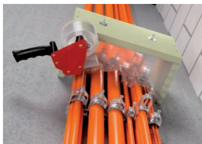
Erstellen einer Schalung zum sicheren Befüllen des Gehäuses.
