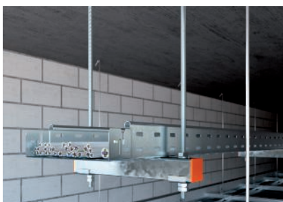
Einlagige Deckenmontage auf Montageschiene.
