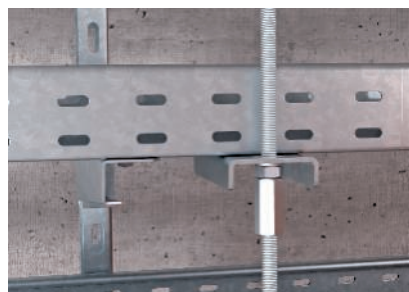
Gewindestangenbefestigung an der Rinne bei mehrlagiger Anordnung.
