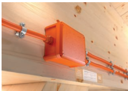
Montage der OBO FireBox am Holzbalken.
