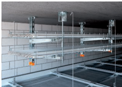
Zweilagige Deckenabhängung mit einseitiger Auslegeranordnung.
