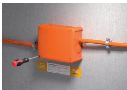
Box mit Deckel schließen und Kennzeichnungsschild anbringen.
