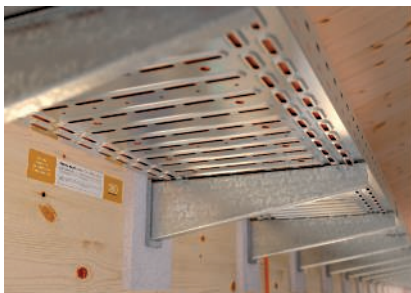
Auslegermontage seitlich am Holzbalken mit hinterlegter Brandschutzplatte.
