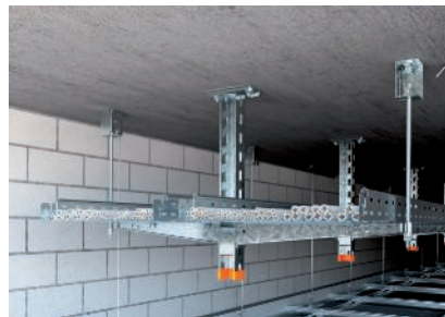
Zweilagige Deckenabhängung mit beidseitiger Auslegeranordnung.
