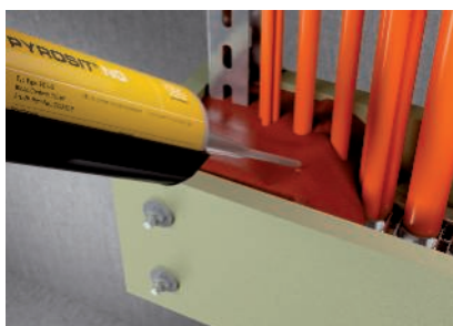
Auffüllen der Kabelzwischenräume mit Brandschutzschaum PYROSIT® NG.
