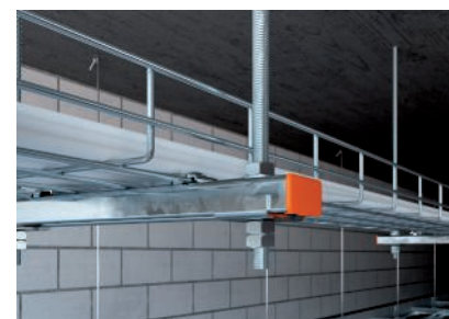
Anschluss der Gewindestange an der Montageschiene.
