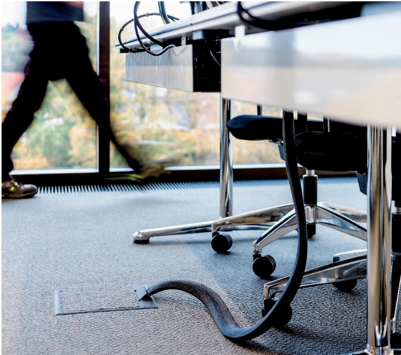
Geräteeinsätze versorgen Arbeitsplätze und andere Punkte mitten im Raum über den Boden mit Strom- und Datenanschlüssen. Es gibt Ausführungen für trocken und für nass gepflegte Böden, in runder und in eckiger Bauform. Als Materialien kommen Kunststoff oder Metall zum Einsatz. Geräteeinsätze eignen sich für den Einbau in
