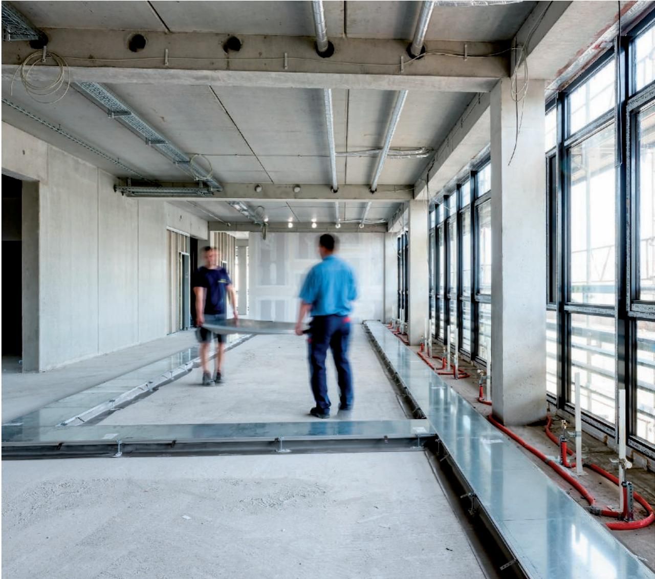
Das offene Kanalsystem OKA ist ein flexibles System für die Kabelführung im Estrich. Die Kanaldeckel lassen sich über die gesamte Länge öffnen - auch im fertig eingebauten Zustand mit Bodenbelag. So kann die Elektroinstallation in den Kanälen jederzeit angepasst werden. Weitere
