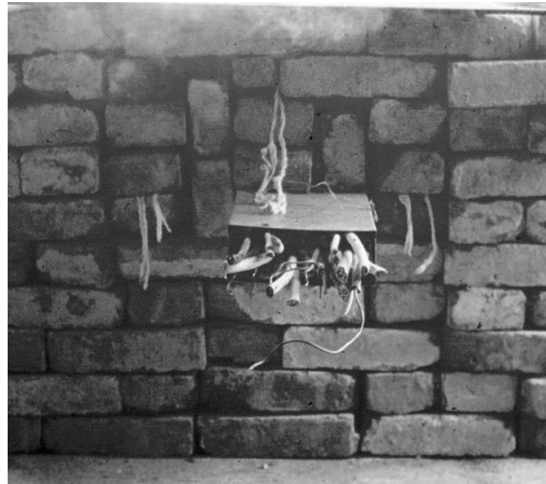
Prüfaufbau der ersten OBO-Kabelabschottung
