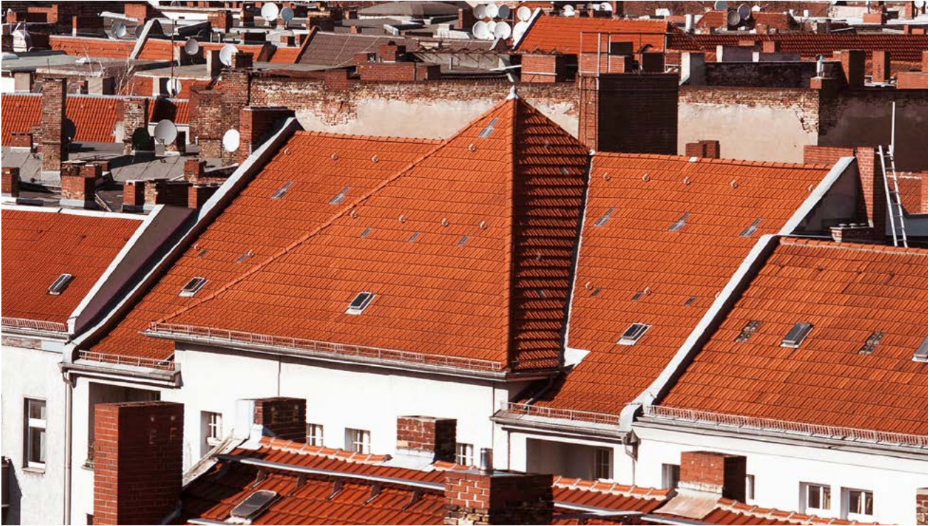
Brandwände verhindern eine Brandausbreitung
