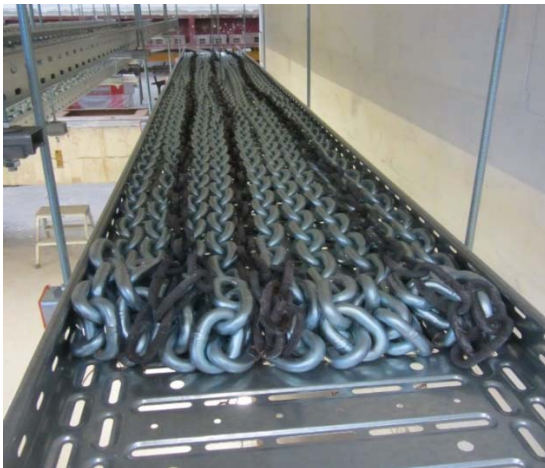
Bild 3: Belegung der Kabelrinnen mit Stahlketten
