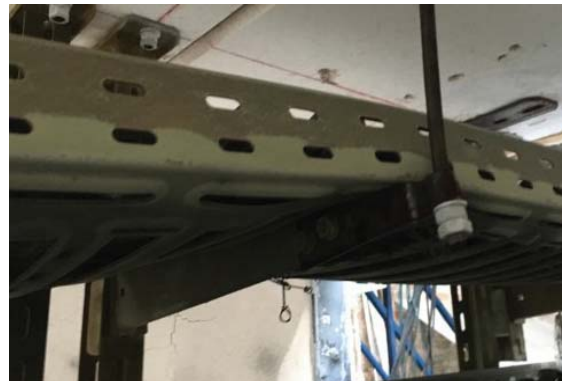
Bild 6: Rinnenmontage auf Ausleger Typ AW 15 41 und Anschlussbauteil AB AW 15
