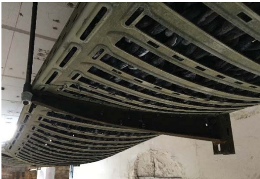
Bild 1: Kabelträgersystem nach der Prüfung Brandbeanspruchung 30 Minuten
