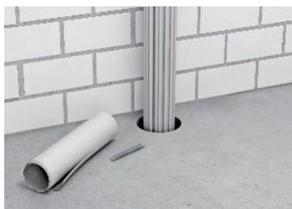
Vorbereitung der Kabelabschottung.
