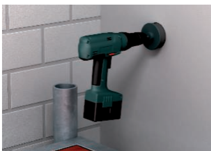
Bohren eines Lochs mit einem Dosenbohrer.
