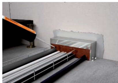
Zwischenräume mit PYROSIT® NG Brandschutzschaum komplett verschließen
