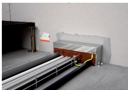
Potentialausgleich anschließen und Kennzeichnungsschild anbringen
