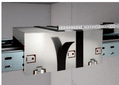
Wanddicke bemessen und Graphitstreifen in entsprechendem Abstand aufbringen
