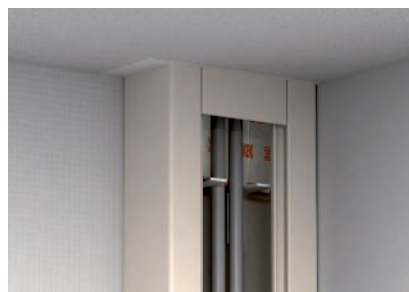
Haltewinkel gegen Herunterrutschen bei senkrechter Anordnung.
