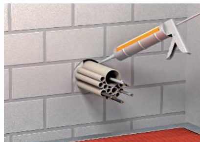
Verschließen der Ringspalte mit Dämmschichtbildner DSX.
