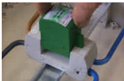
C) Steckbarer Blitzstromableiter mit V-Anschluß
