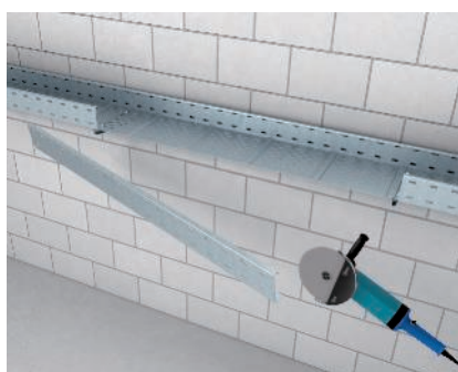
Realizzazione di una derivazione a T con curva Rimuovere il fianco della passerella.
