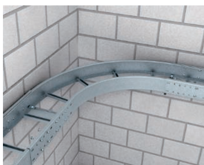
Montaggio della curva 90° Curva per passerella a grande portata. La curva viene collegata alla passerella con giunti esterni.
