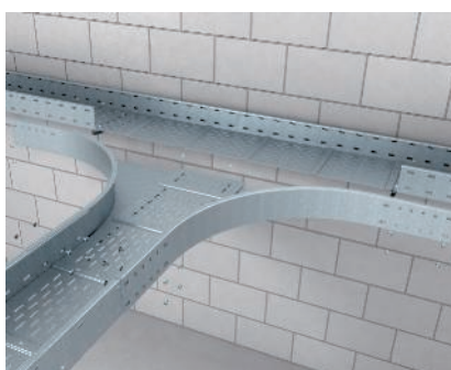
Realizzazione di una derivazione a T con curva Installazione della derivazione laterale.
