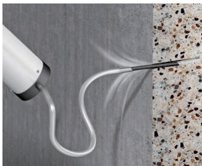
Pulizia del foro Soffiaggio del foro per la pulizia con soffiatore manuale o aria compressa
