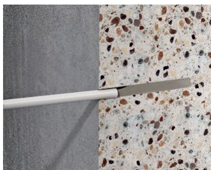
Applicazione della malta da iniezione Premere la malta nel foro.
