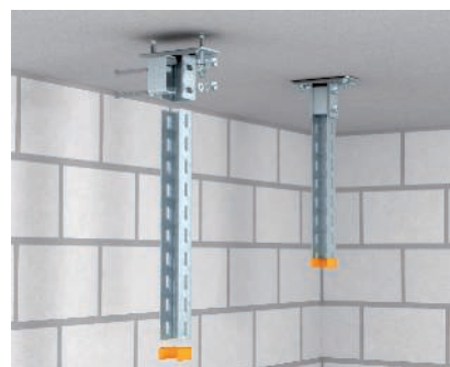
Montaggio di supporti a soffitto
