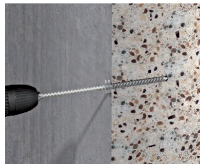
Pulizia con spazzola in acciaio Pulizia a macchina del foro con spazzola in acciaio. Il processo di pulizia con soffiaggio e spazzola deve essere eseguito due volte.
