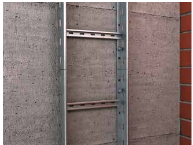
Direkte Montage der Steigleiter an der Massivwand.
