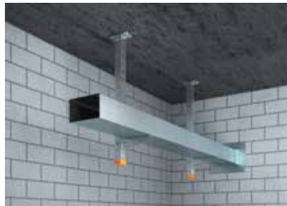
Abgehängte Montage auf Kabeltrag-system
