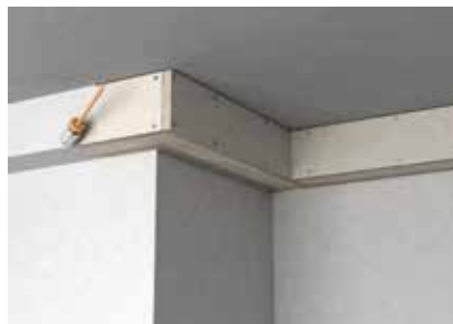
Abschließende Oberflächenbehand- lung durch Streichen oder Tapezieren.
