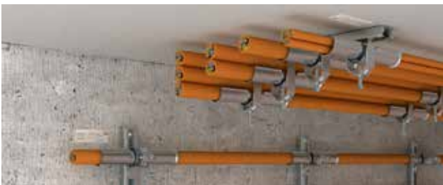
Waagrechte Montage mit Bügelschellen und Langwannen an der Wand und unter der Decke.
