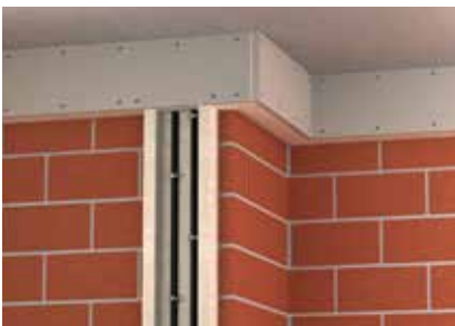
Kabelbefestigung bei senkrechter Kanalmontage mit Schellen.
