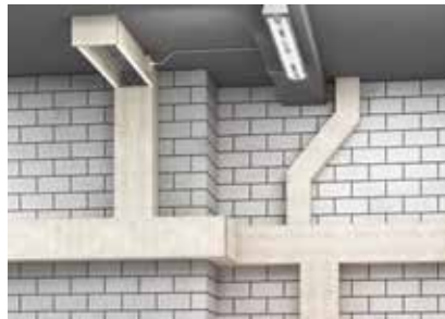
Montierter Brandschutzkanal an Wand und Decke
