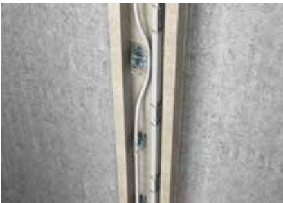
Senkrechte Kabelverlegung mittels Leitungshalter
