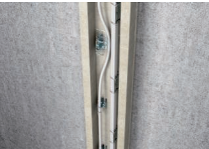
Posa verticale dei cavi mediante supporto cavi
