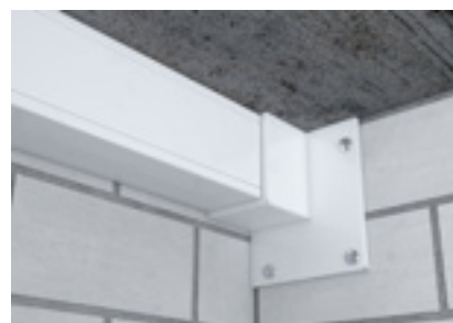
Montage dans le coin de la pièce
