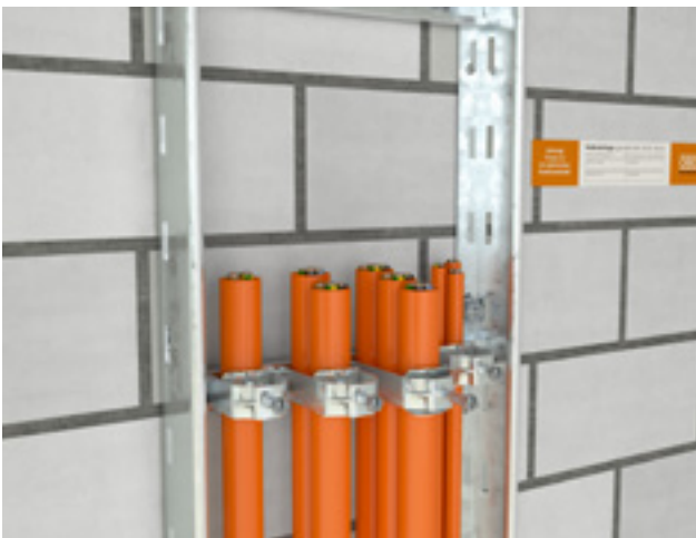
Fixation des câbles individuellement ou en faisceau avec des Bride de fixation.
